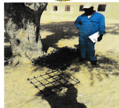
Photo 5: ferrailage des semelles
