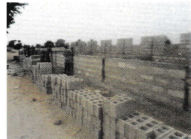
Photo 10: élévation des murs des 4 premières salles de classe
