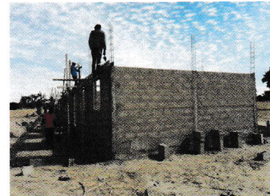
Photo 11: élévation des murs des 4 salles de classe restantes
