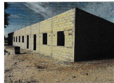
Photo 12: aperçu des 4 premières salles de classe
