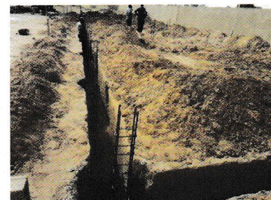
Photo 7: fondation salle de classe
